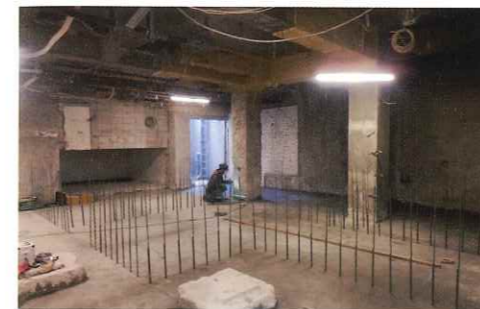
大浴場施工状況
