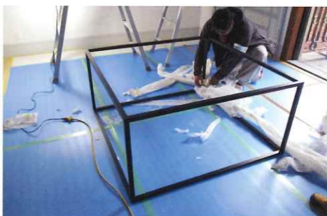
客室照明施工状況
